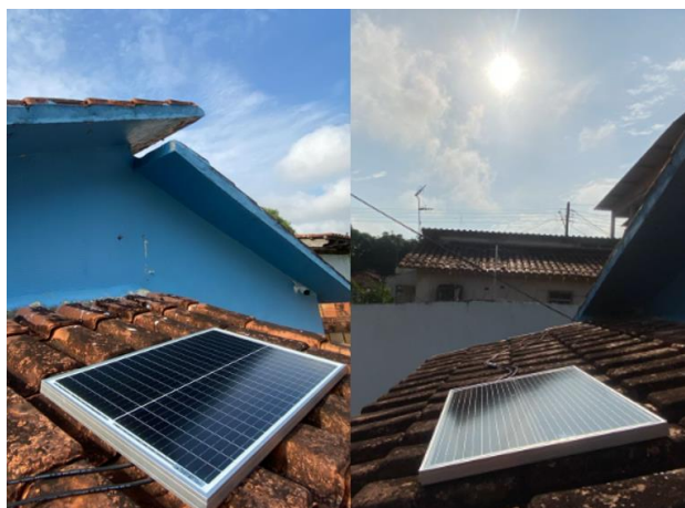
Figura 18 - Fixação do módulo fotovoltaico.
